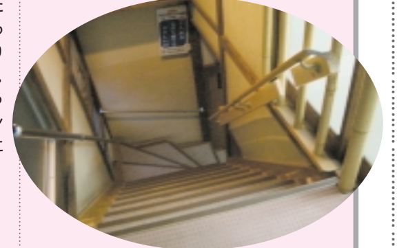
バリアフリー施工後の階段 事業にも参加者が増えたそうです
